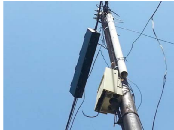
Gambar 7. Tiang telepon terbuat besi dilapisi seng
